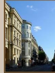
46 bis & 48-52 rue du Louvre
